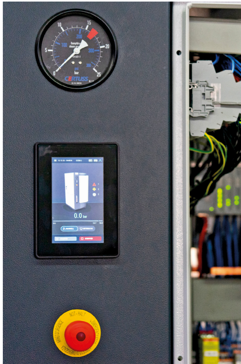
Interfejs graficzny sterownika HMI TX705 został gruntownie zmodernizowany w ścisłej współpracy z firmą Turck, aby zapewnić użytkownikowi dokładnie taki komfort obsługi, jaki określiła firma Certuss
